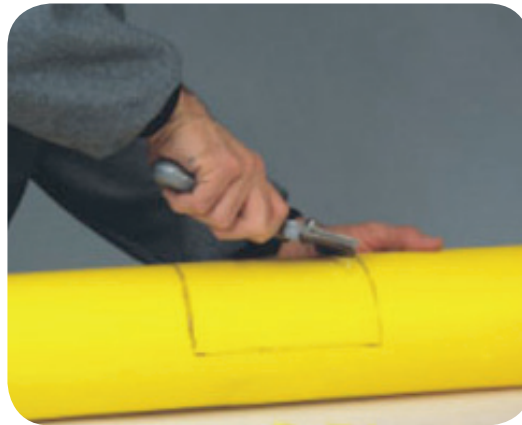
Oksitli tabakanın traşlanması/ Scraping the oxide layer
